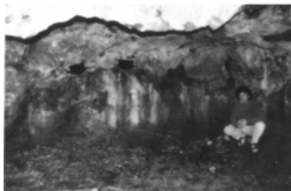
Photo 3 — Limite de remplissage imprimée sur la paroi.
